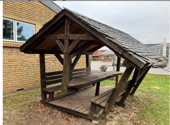
Redskab: Bord bæk sæt Ikke omfattet af DS/EN 1176 Da der er stor aktivitet på redskabet, bør det repareres.
